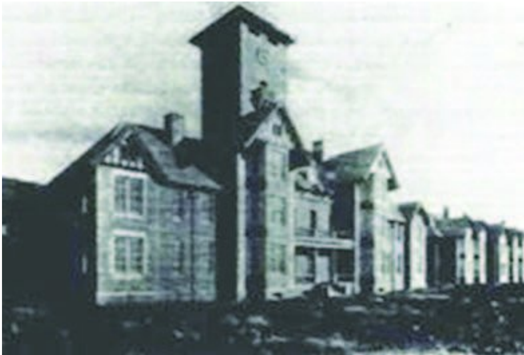
'n Noord-oostelike aansig op die gebou
