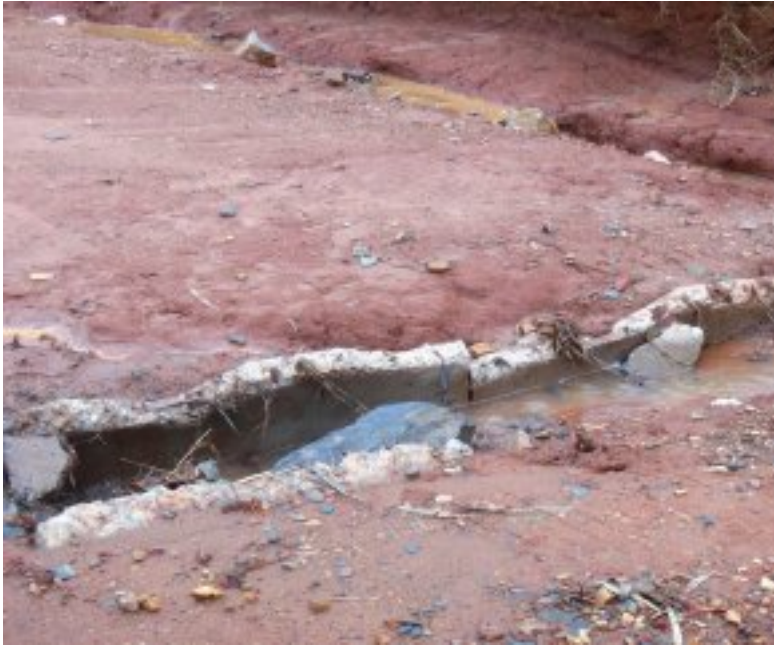
'n Stukkende waterpyp op die Rhenosterfonteinpad beskadig voertuie Foto: Chamanda Prinsloo
