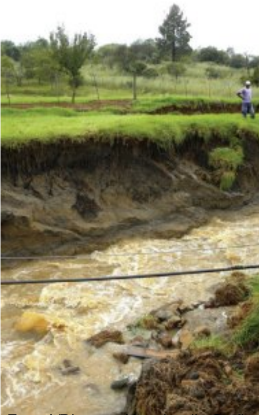
Foto: Liba Die waterloop by die Stefberg se damwal uitgeloop het 'n donga van ongeveer drie meter v
