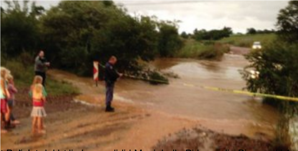
Die Meeplaatsgrondpad op Zwavelpoort. Die water is so hoog dat die Meeplaatsgrondpad nie gebruik kan word nie. Foto: Mike Stringer
